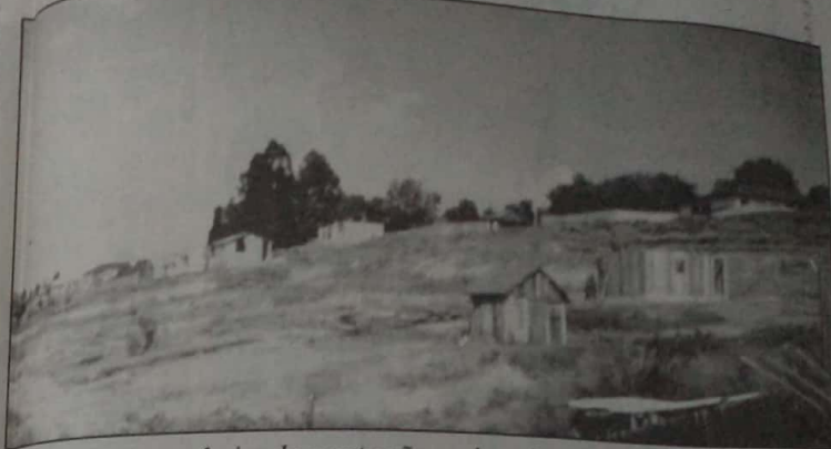
Uma panorâmica da construção nos lotes doados pela Prefeitura.
