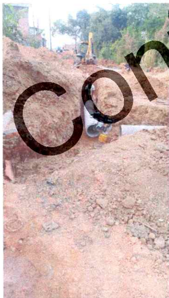
FOTO 05: TRECHO ONDE HOUVE NECESSIDADE DE AMPLIAÇÃO DE REDE PARA SUPOSTAR VOLUME A MONTANTE DA VIA PARA ASSEGURAR CAPTAÇÃO DE ÁGUA PLUVIAIS
