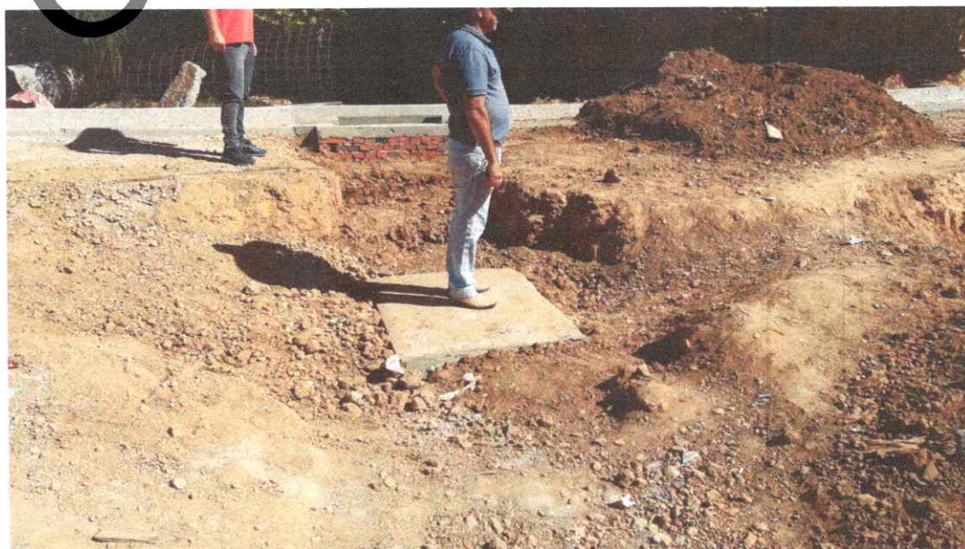
FOTO 02: CAIXA DE LIGAÇÃO ADICIONADA PARA READEQUAR SISTEMA EXISTENTE
