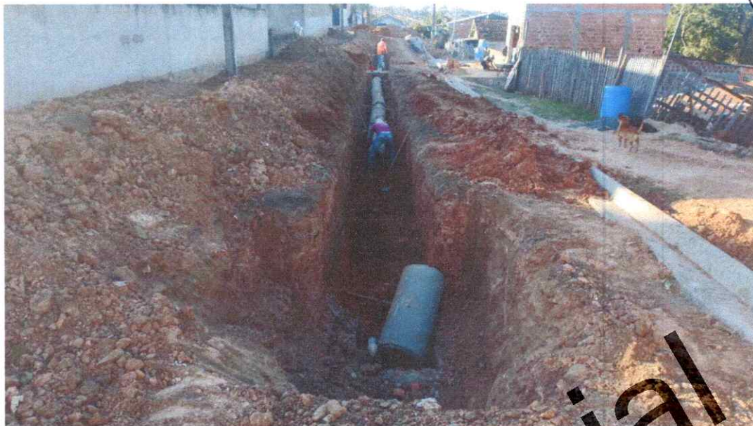
FOTO 05: TRECHO ONDE HOUVE NECESSIDADE DE AMPLIAÇÃO DE REDE PARA SUPOSTAR VOLUME A MONTANTE DA VIA PARA ASSEGURAR CAPTAÇÃO DE ÁGUA PLUVIAIS
