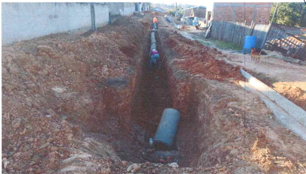
FOTO 05: TRECHO ONDE HOUVE NECESSIDADE DE AMPLIAÇÃO DE REDE PARA SUPORTAR VOLUME A MONTANTE DA VIA PARA ASSEGURAR CAPTAÇÃO DE ÁGUA PLUVIAIS
