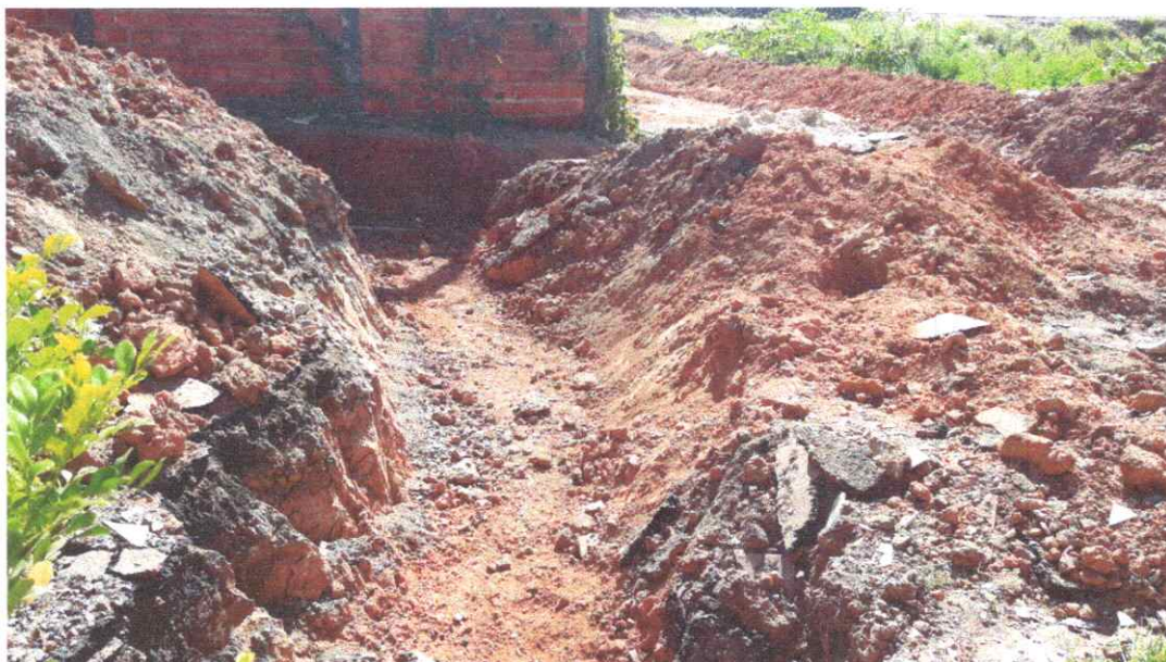
FOTO 03: ABERTURA DE VALA PARA INSTALAÇÃO DE NOVOS DISPOSITIVOS DE DRENAGEM
