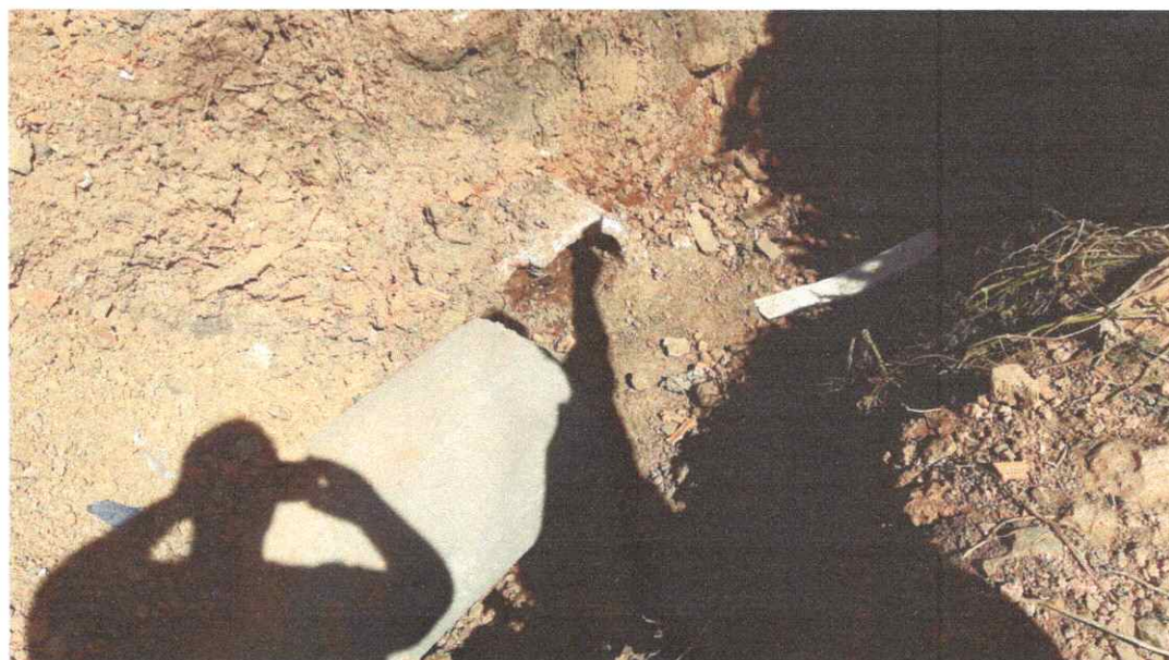
FOTO 04: INSTALAÇÃO DE NOVA CAIXA DE LIGAÇÃO PARA REAQUAÇÃO DO SISTEMA.
