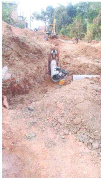
FOTO 05: TRECHO ONDE HOUVE NECESSIDADE DE AMPLIAÇÃO DE REDE PARA SUPORTAR VOLUME A MONTANTE DA VIA PARA ASSEGURAR CAPTAÇÃO DE ÁGUA PLUVIAIS
